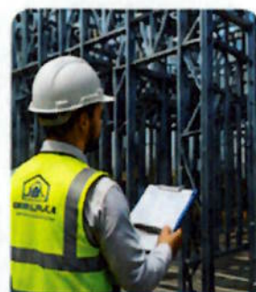
VERIFICACIÓN EN OBRA
